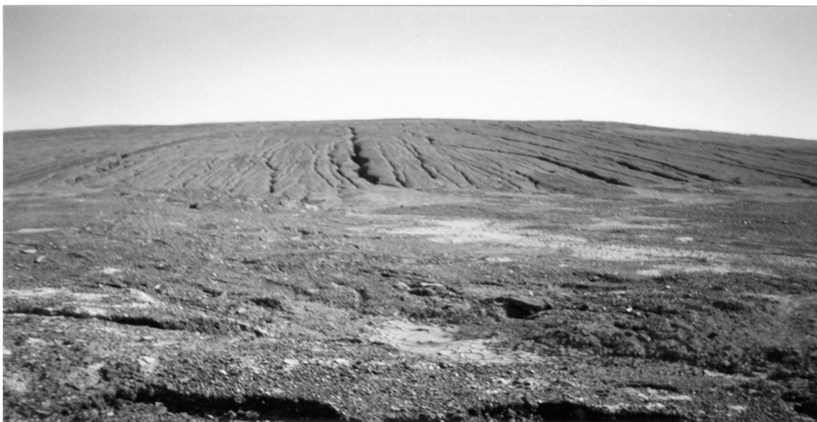
Рисунок 1. «Бороздки» и «овраги» на склоне отвала шахты им. Костенко. Фото К.М. Акпамбетовой
