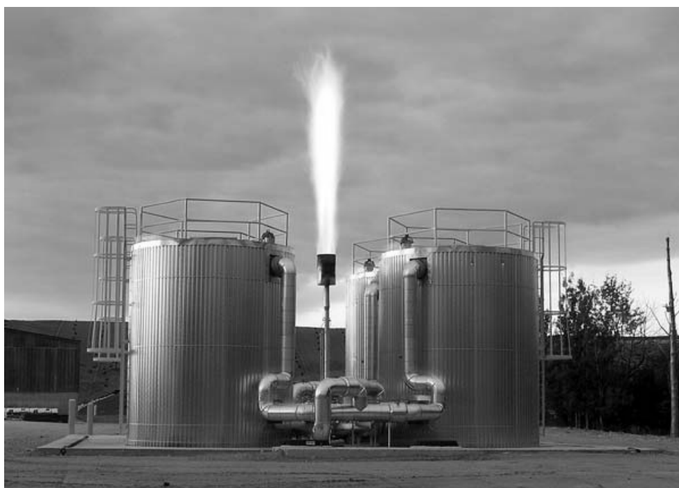
Рисунок 5. Пример факела для сжигания полигонного газа
