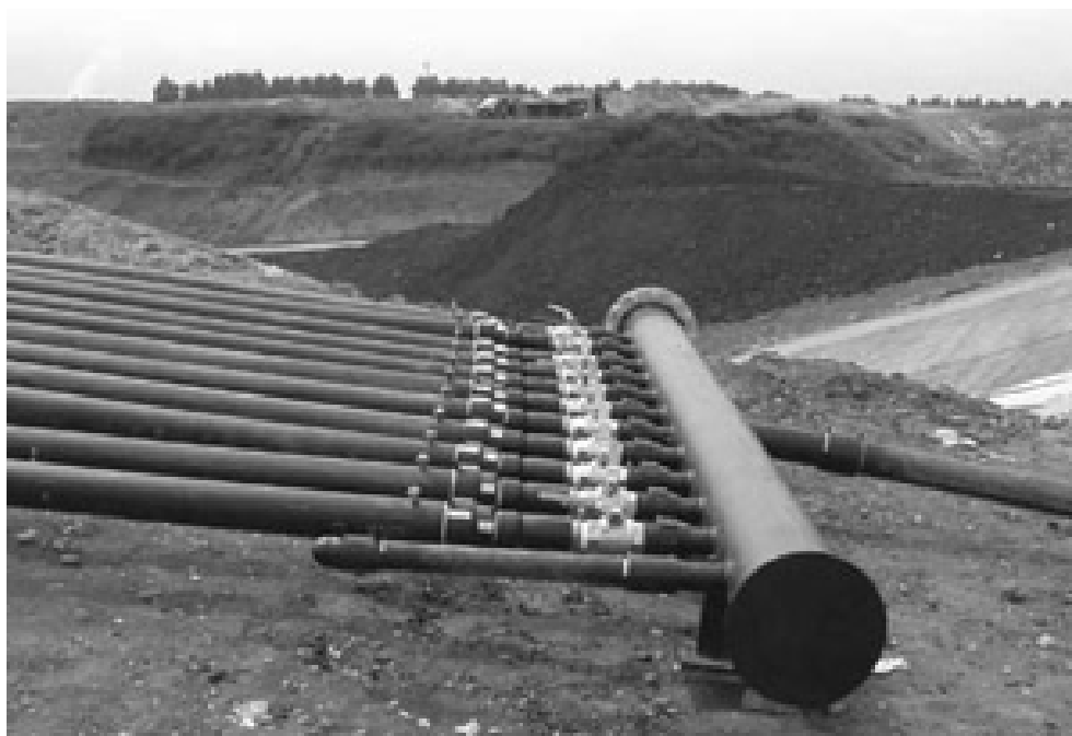
Рисунок 4. Закладка горизонтального коллектора полигонного газа
